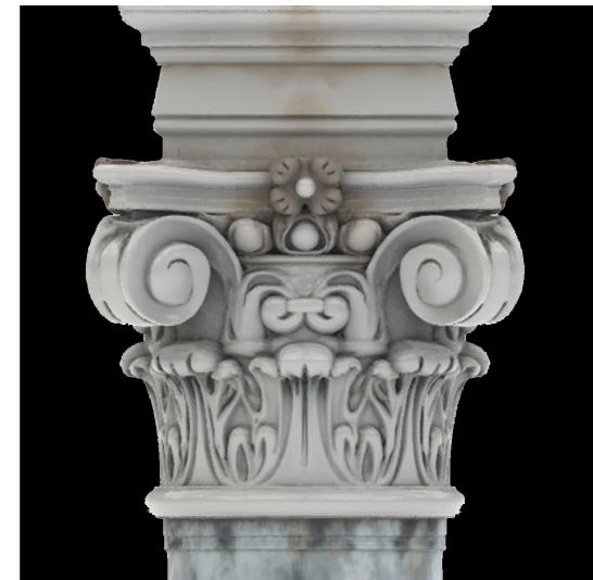
Fig. 16. Comparazione tra il modello del capitello composito generato con la procedura Structure from Motion (a sinistra) e il modello generato a partire da una singola fotografia con AI (a destra) (elab. Ferdinand Rexhaj).
