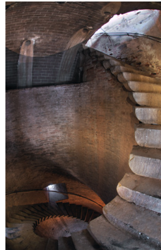
Fig. 4. La particolare struttura elicoidale si conclude bruscamente in una normale cella campanaria simile a quella di molti altri campanili.
