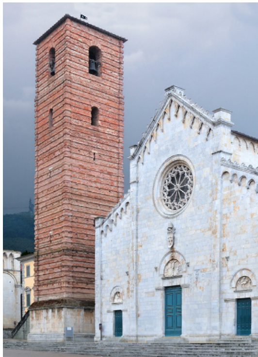
Fig. 1. Il campanile del Duomo di San Martino a Pietrasanta. Il paramento laterizio avrebbe dovuto avere un rivestimento marmoreo come la facciata della chiesa.
