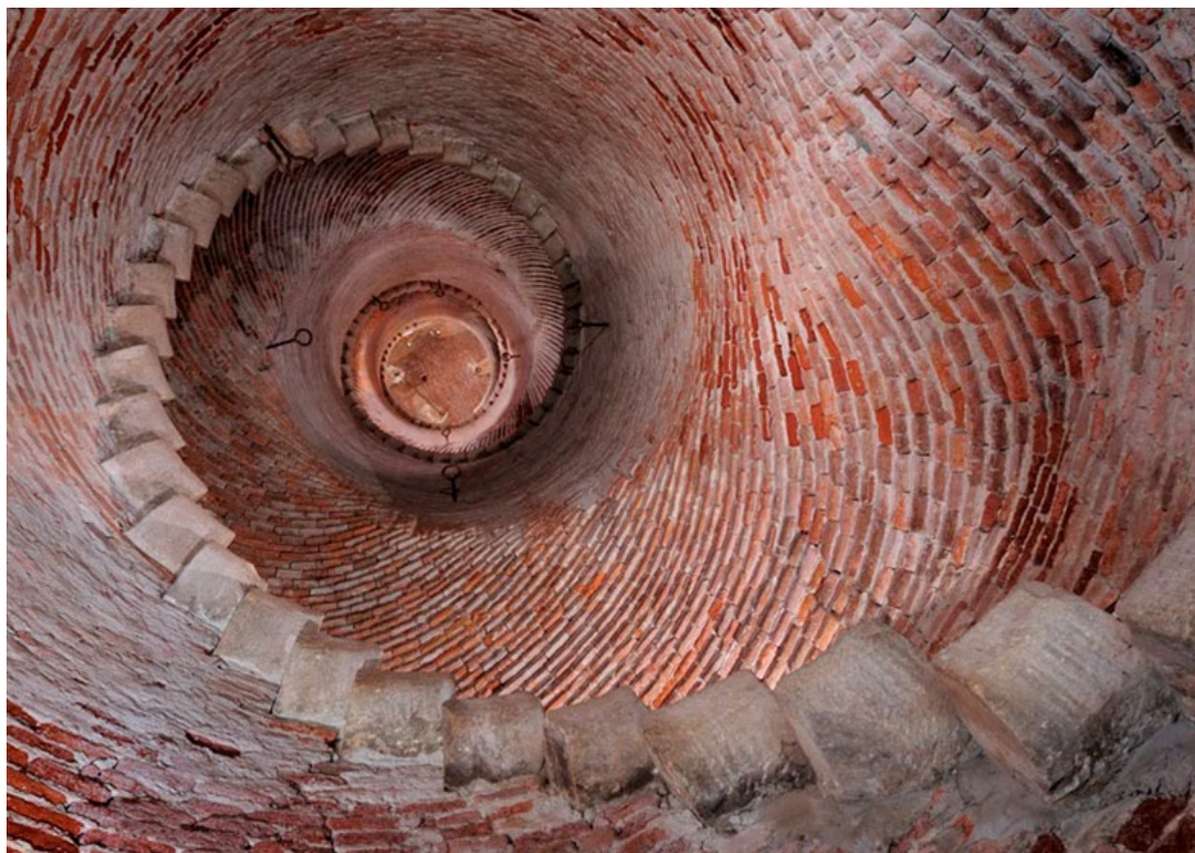
Fig. 12. Prospettiva dal basso dell'interno. Si notano i ricorsi regolari dei mattoni che generano la particolare curvatura della superficie.
