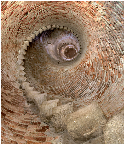
Fig. 22. La superficie elicoidale vista dal basso. Al centro si percepisce la colonna immaterica definita dalle superfici laterizie su cui poggiano i gradini marmorei.
