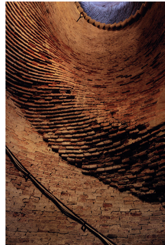
Fig. 27. L'errore all'inizio della costruzione dell'elica.
