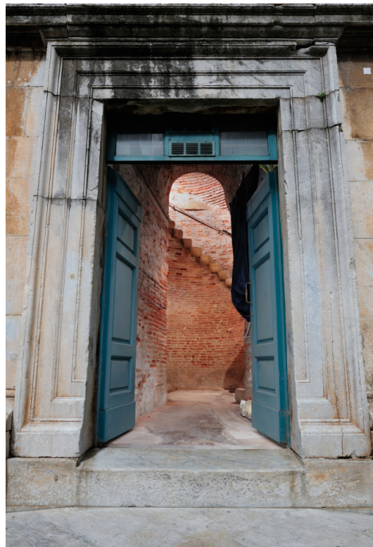
Fig. 10. L'ingresso al campanile nel dado di base.
