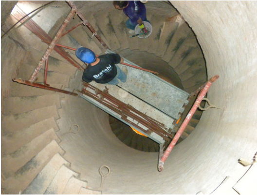
Fig. 5. Il ponteggio realizzato per eseguire il rilievo tridimensionale..
