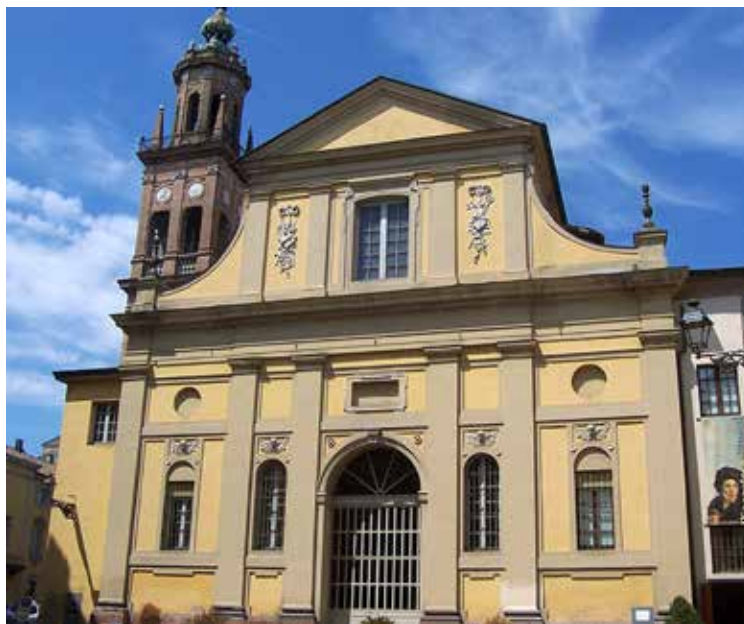
Fig. 1. La facciata della ex-chiesa di San Ludovico nella sua attuale configurazione.
