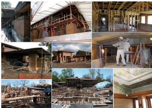
Fig.29 - Darwin D. Martin House, Buffalo. Immagini dei lavori di restauro.
