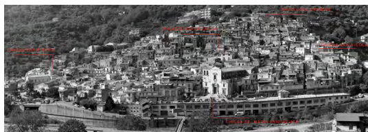
Fig.4. Fiumedinisi, localizzazione delle scansioni laser
