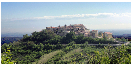
Fig. 5 Vista sud-est di Brittoli
