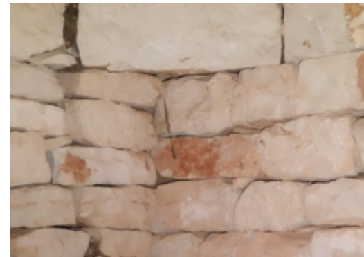
Fig 2. Posa del primo anello di chiancarelle di copertura.
