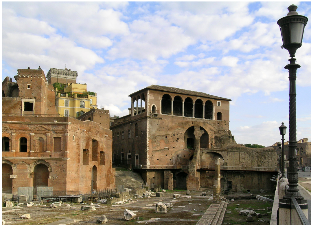
Fig. 1. La Casa dei Cavalieri di Rodi nel contesto dell'area archeologica dei Fori imperiali.
