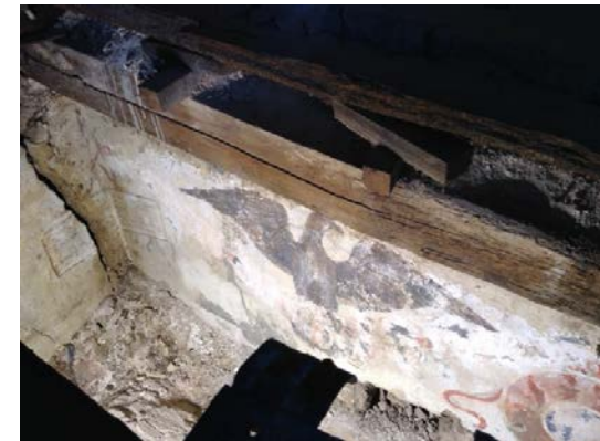
Fig. 1 Le tracce di decorazioni pittoriche, così come rinvenute nel corso di un saggio sotto un solaio ligneo.
