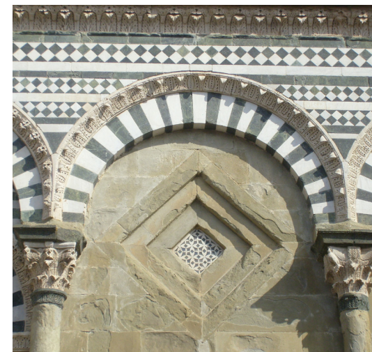
Sopra Fig.17 – Particolare della facciata. La ghiera dell'arco nella campata di 10 piedi (tipo a) ospitante, nella muratura piena la formella quadrata.
