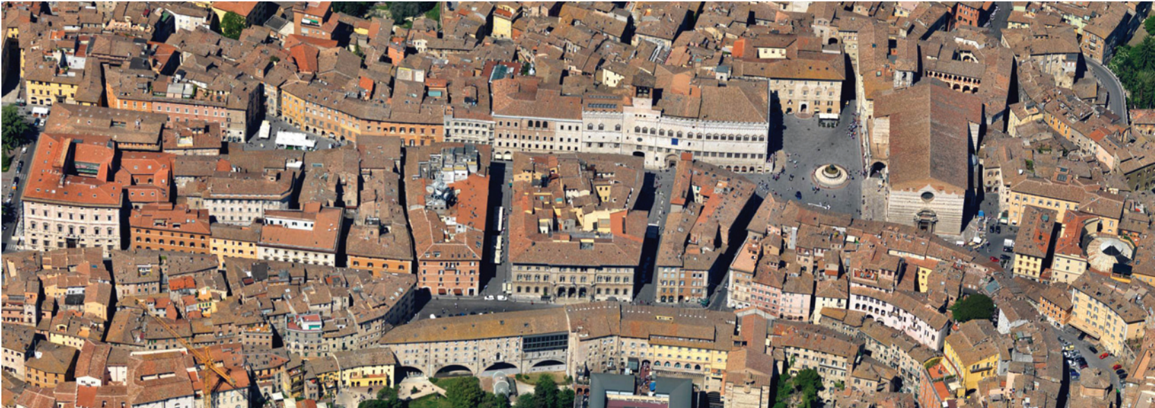
Fig.1 Perugia, vista aerea dell'acropoli
