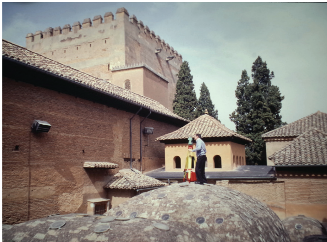
Fig. 1 - Antonio Almagro sobre las bóvedas del baño del Palacio de Comares. Palacio de la Alhambra. Granada, 2000.
