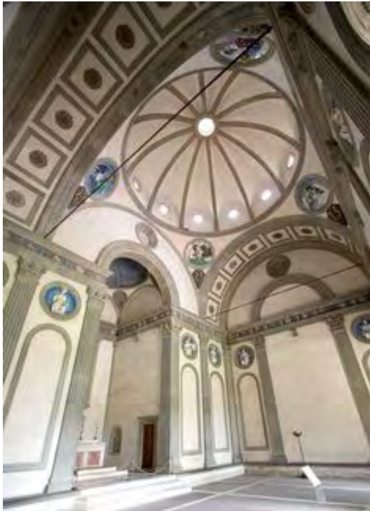
Fig. 5 Vista dall'interno della volta a ombrello
